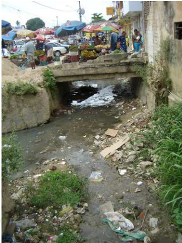
Estrangulamento da seção do canal, agravado pelo acúmulo de lixo.
