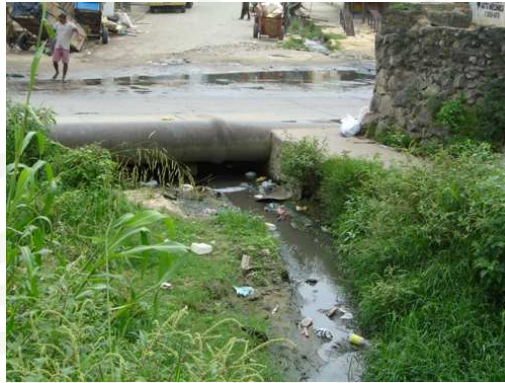
Estrangulamento da seção do canal, agravado pelo acúmulo de lixo.
