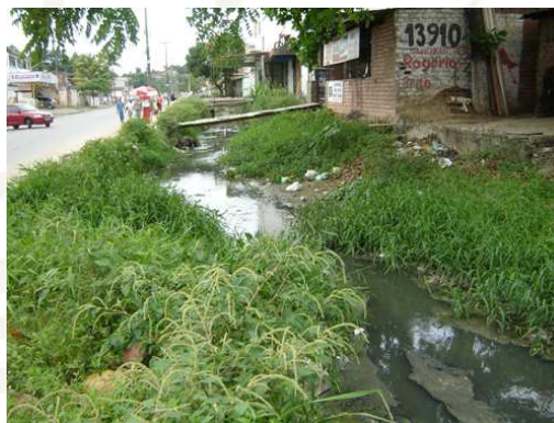
Trecho com seção obstruída pelo mato devido à falta de limpeza periódica.
