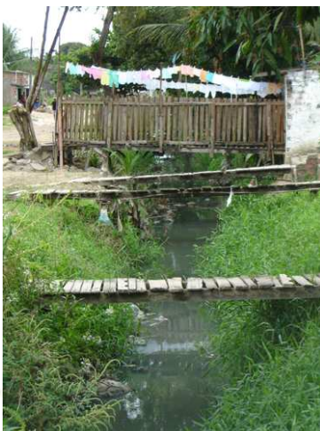
Trecho com seção obstruída pelo mato devido à falta de limpeza periódica.
